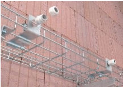
Montage d'un support presse étoupe
