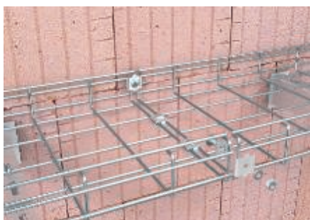
Montage linéaire du chemin de câbles en treillis en C à l'aide d'éclisses à boulonner type GSV 34.
