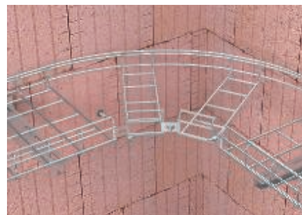
Montage de coudes horizontaux avec le chemin de câbles en treillis en C à l'aide des éclisses d'angle type GEV 36.
