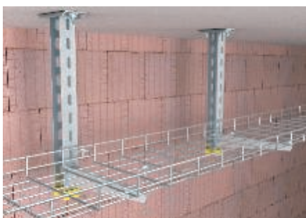
Montage du chemin de câbles en treillis avec les pendants type US 3 K et les consoles type AW 15.
