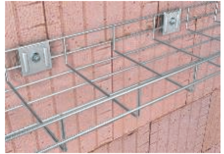
Montage direct au mur des chemins de câbles en treillis
